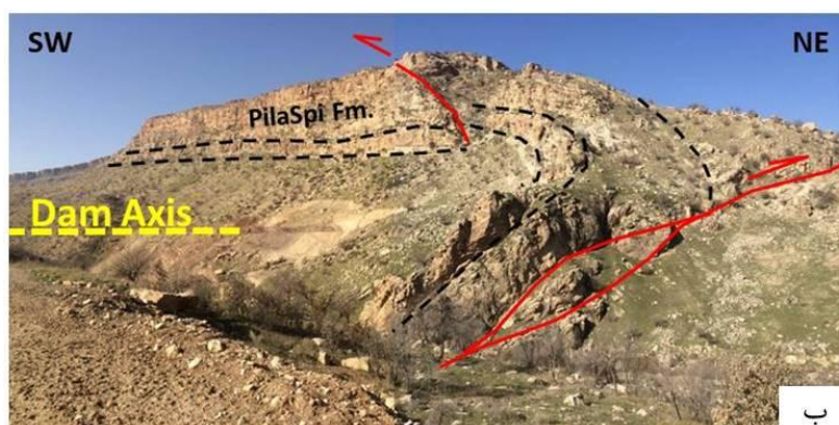
شکل ۳- وضعیت زمین شناسی تکیه گاه راست سد. الف) سازندهای زمین شناسی موجود در تکیه گاه راست؛ ب) گسل های مرتبط با چین خوردگی در پهلوی شمال خاوری تاقدیس در مجاورت محور سد
