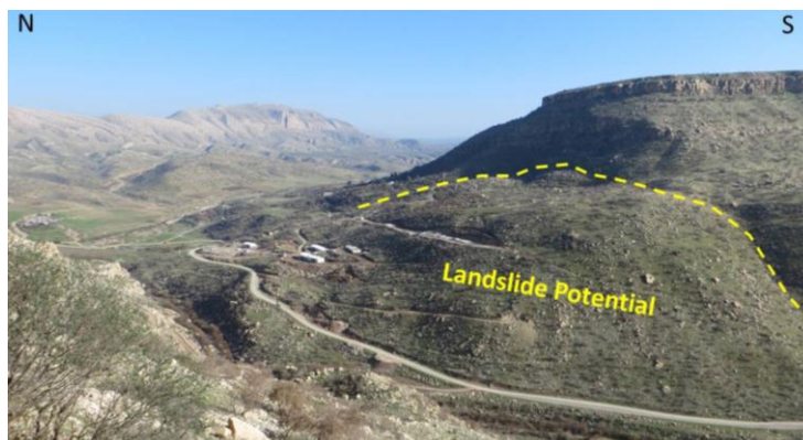
شکل ۲- وضعیت تکیه گاه چپ سد و وجود توده مستعد زمین لغزش (Landslide Potential)
