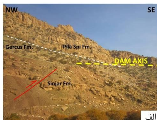
شکل ۳- وضعیت زمین شناسی تکیه گاه راست سد. الف) سازندهای زمین شناسی موجود در تکیه گاه راست؛ ب) گسل های مرتبط با چین خوردگی در پهلوی شمال خاوری تاقدیس در مجاورت محور سد
