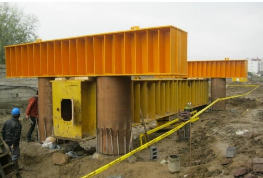
شکل ۱- تصویری از بارگذاری شمع‌های بتنی درجاریز (پژوهش عمران راهوار، ۱۳۹۸)
