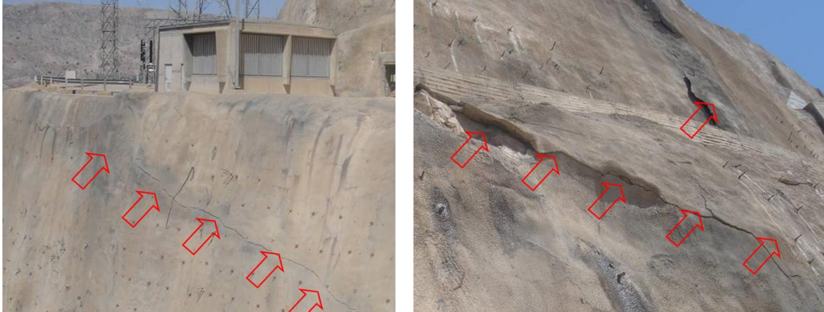
شکل ۱. ترک‌های ایجاد شده روی سطح شاتکریت به همراه ریزش بخش‌هایی از برم‌های مشرف به ترانشه
