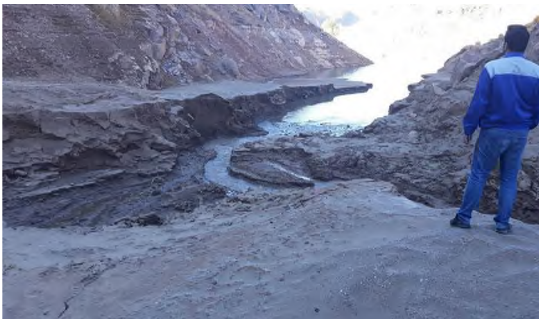
شکل ۲- تصویری از رسوبات انباشت شده در انتهای مخزن سد زنوز
