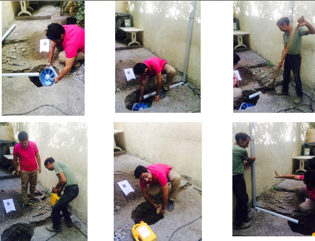
شکل ۳: نمونه اجرای پروژه کاهش تجمع گاز رادون در ساختمان نمونه در منطقه کوه سنگی مشهد
